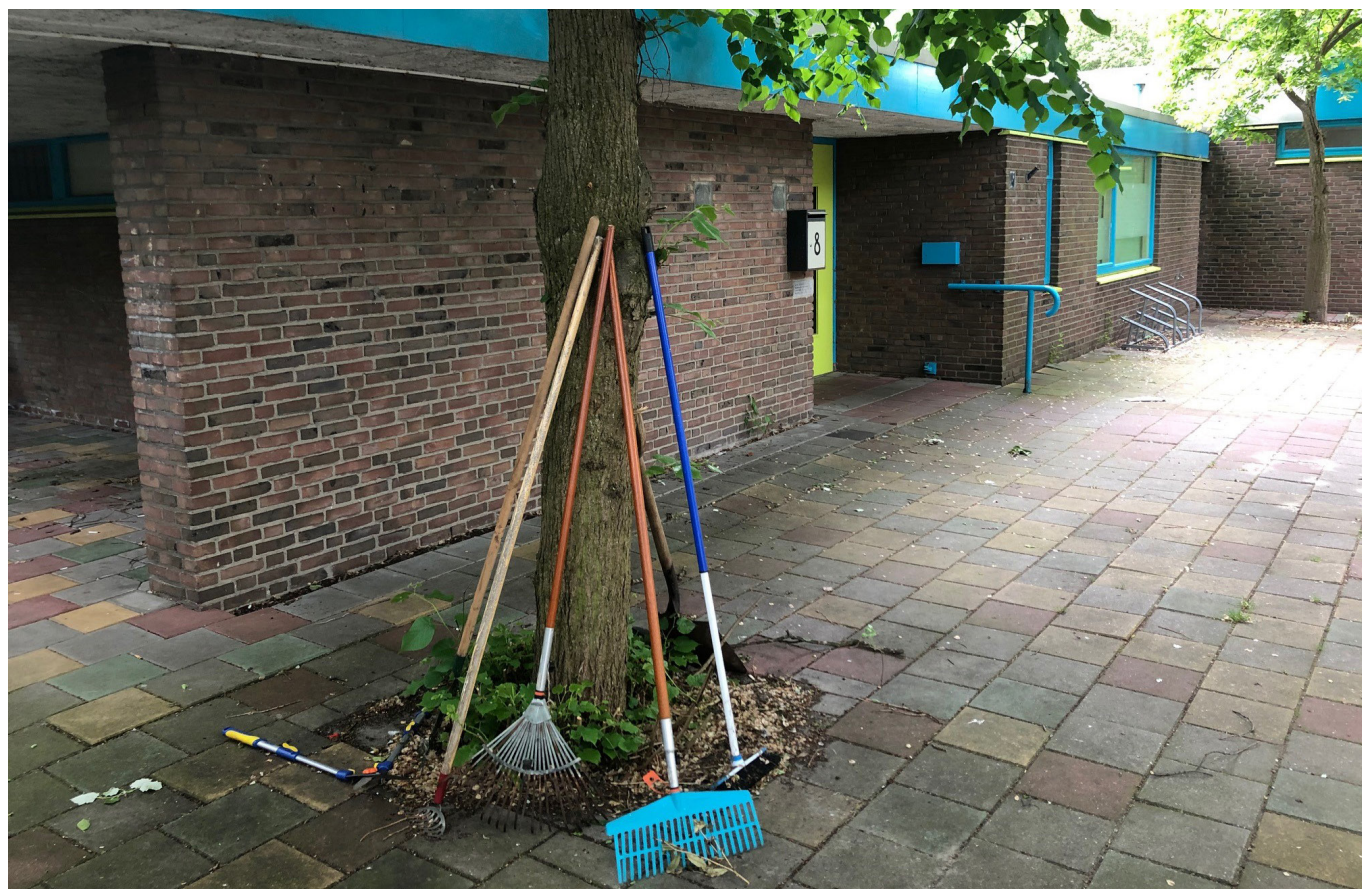
Eerste werkzaamheden in augustus 2019
